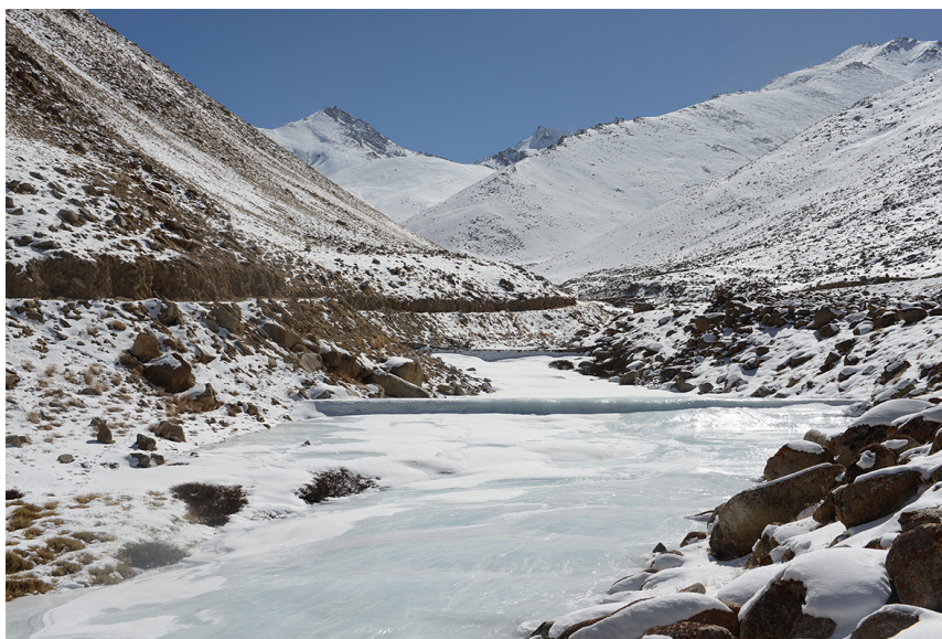
Abb. 4.3-2: Eisreservoir in Ladakh bei 4300 m. Das Bachbett im Vordergrund und die Steinmauern sind mit Eis überflossen (Foto: M. Nüsser - 25. Februar 2014).
